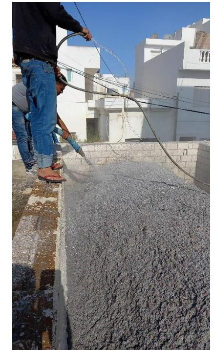
C'est un isolant thermique et acoustique, il permet d'avoir **10 degrés de différence** entre la température de l'intérieur et de l'extérieur. C'est écologique; il est obtenu à partir du papier journal recyclé, c'est facile et simple à appliquer, ça ne dégage aucun gaz nocif à l'intérieur.
